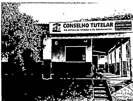
FOTO 03 - VISTA DA FACHADA
