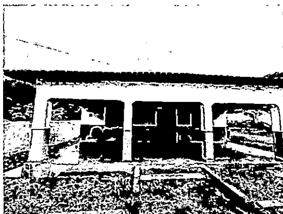
FOTO 03 - VISTA DA FACHADA FRONTAL
