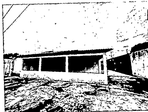
FOTO 04 – VISTA 1 DA GARAGEM
