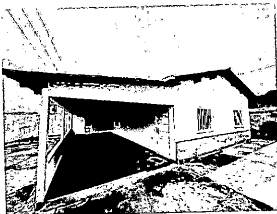
FOTO 03 - VISTA DA FACHADA FRONTAL
