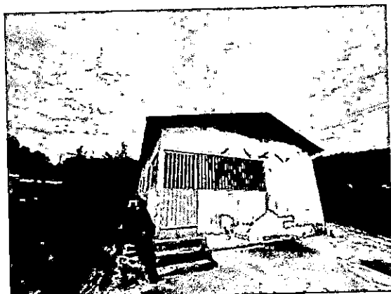
FOTO 05 – VISTA DA FACHADA POSTERIOR
