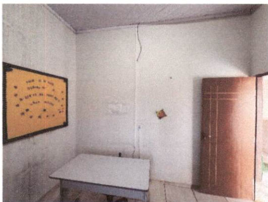
FOTO 11 - VISTA INTERNA 1 DA SALA 3
