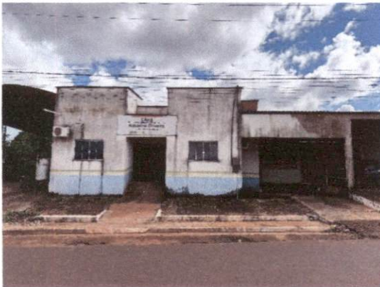
FOTO 03 - VISTA DA FACHADA
